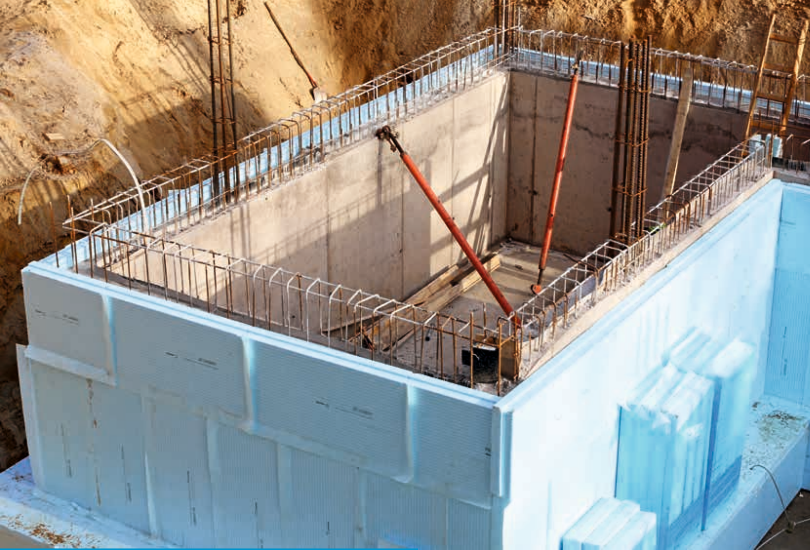
XPS UYGULAMA Su sızdırmazlık ve Yalıtım örnek uygulama
